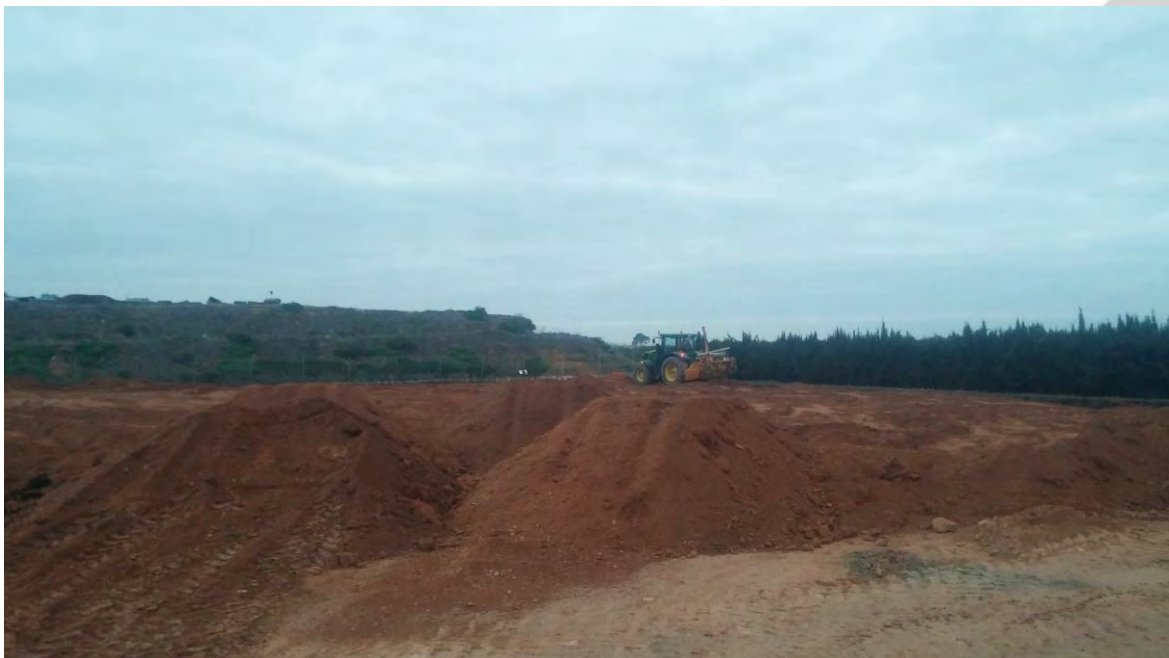
Relleno de la parcela
