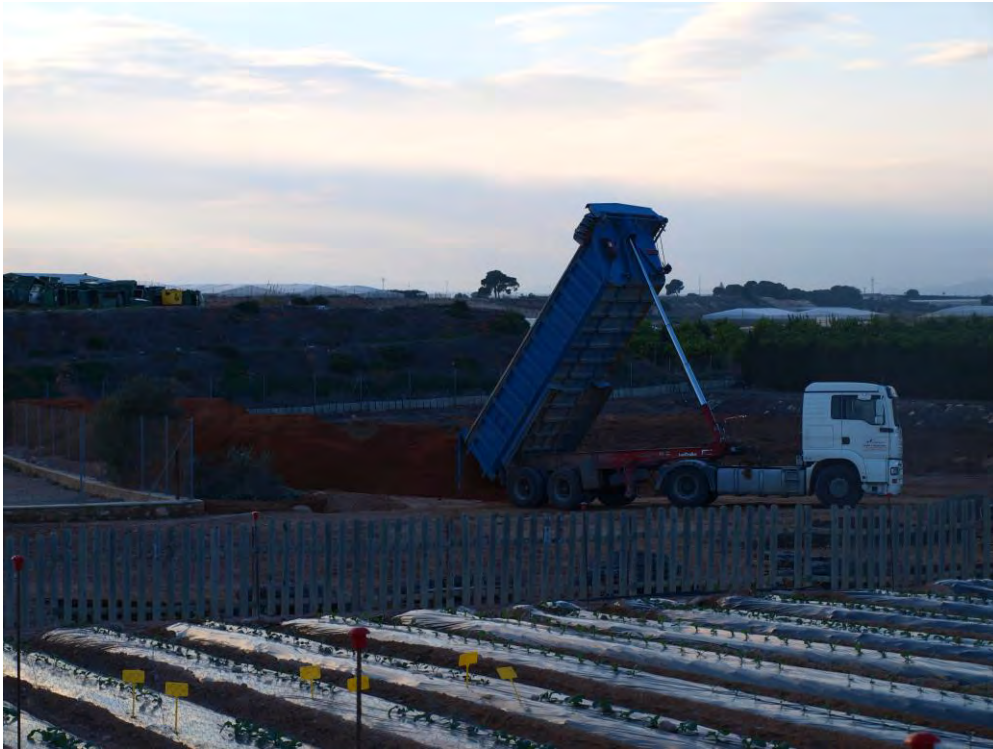
Aportaciones de tierra al terreno para el relleno
