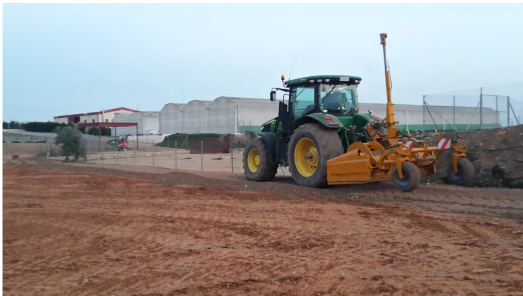
Nivelado parcela para ensayos
