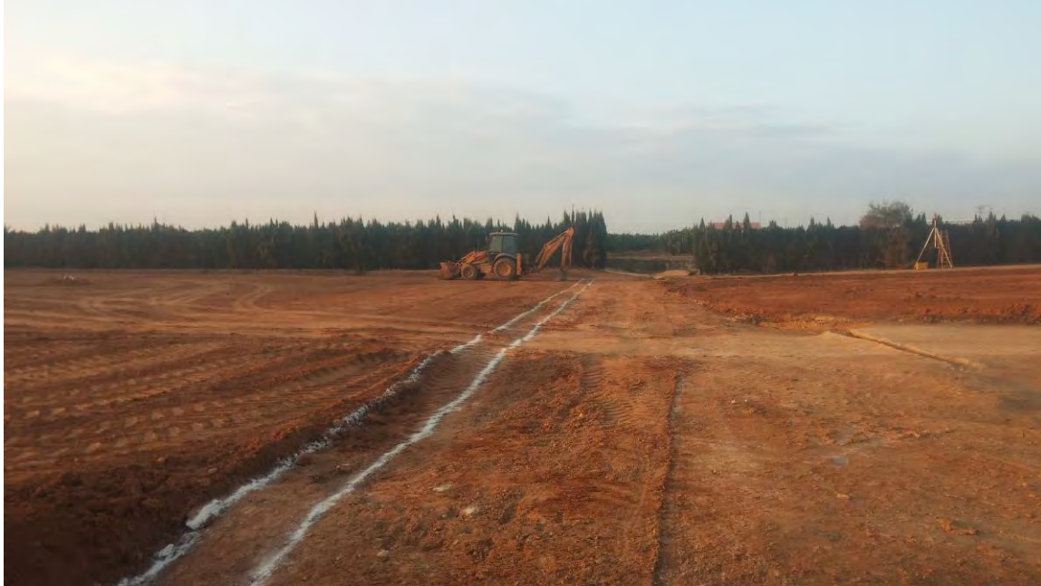
Preparación de surco para la separación del camino y la parcela y para la circulación de agua en caso de lluvia
