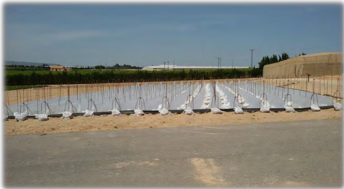
Imagen nº8 Estado parcela con manta térmica 24/04/17
