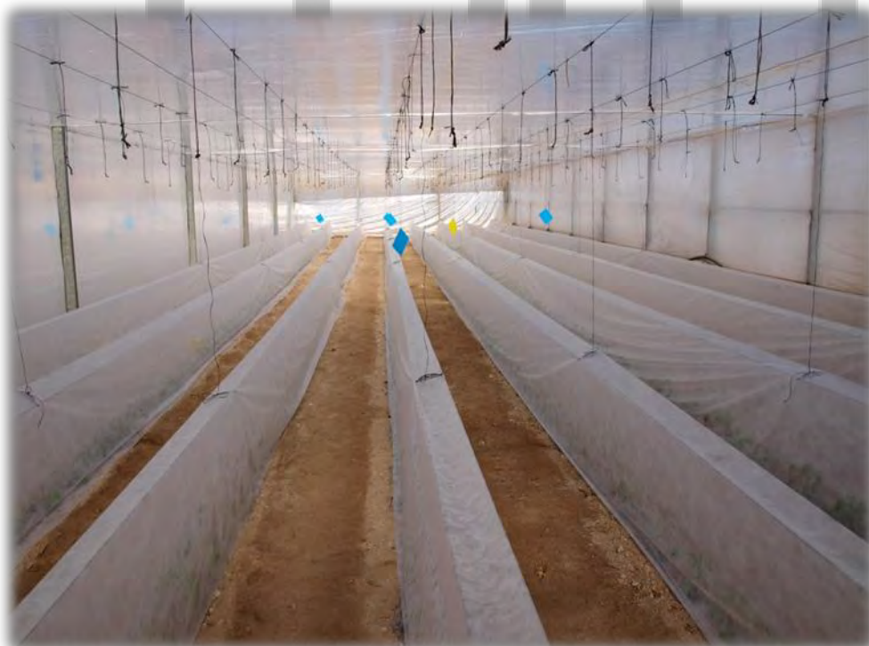
Imagen nº6 Manta térmica en invernadero
