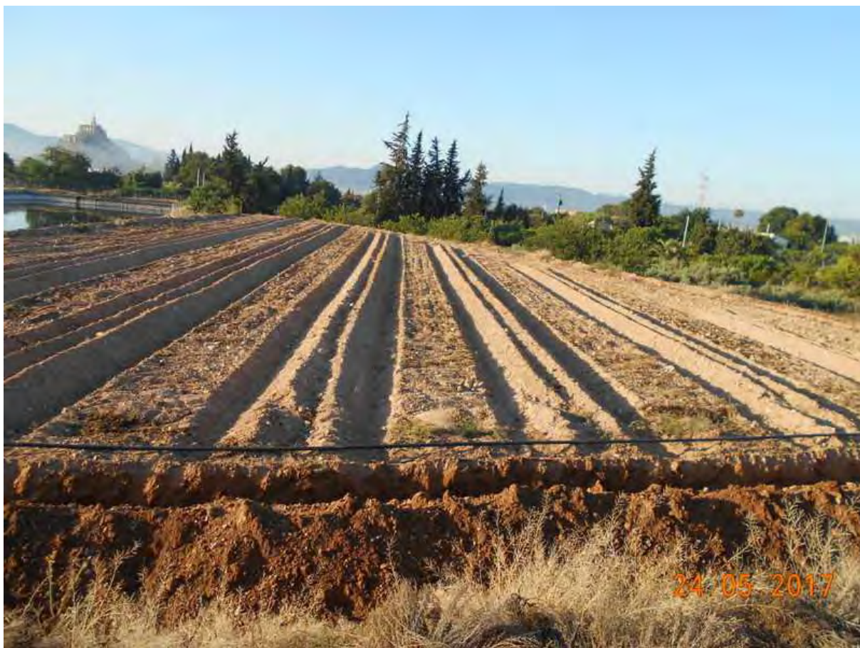
Fotografía 2. Apertura de zanja para instalación de tubería de riego
