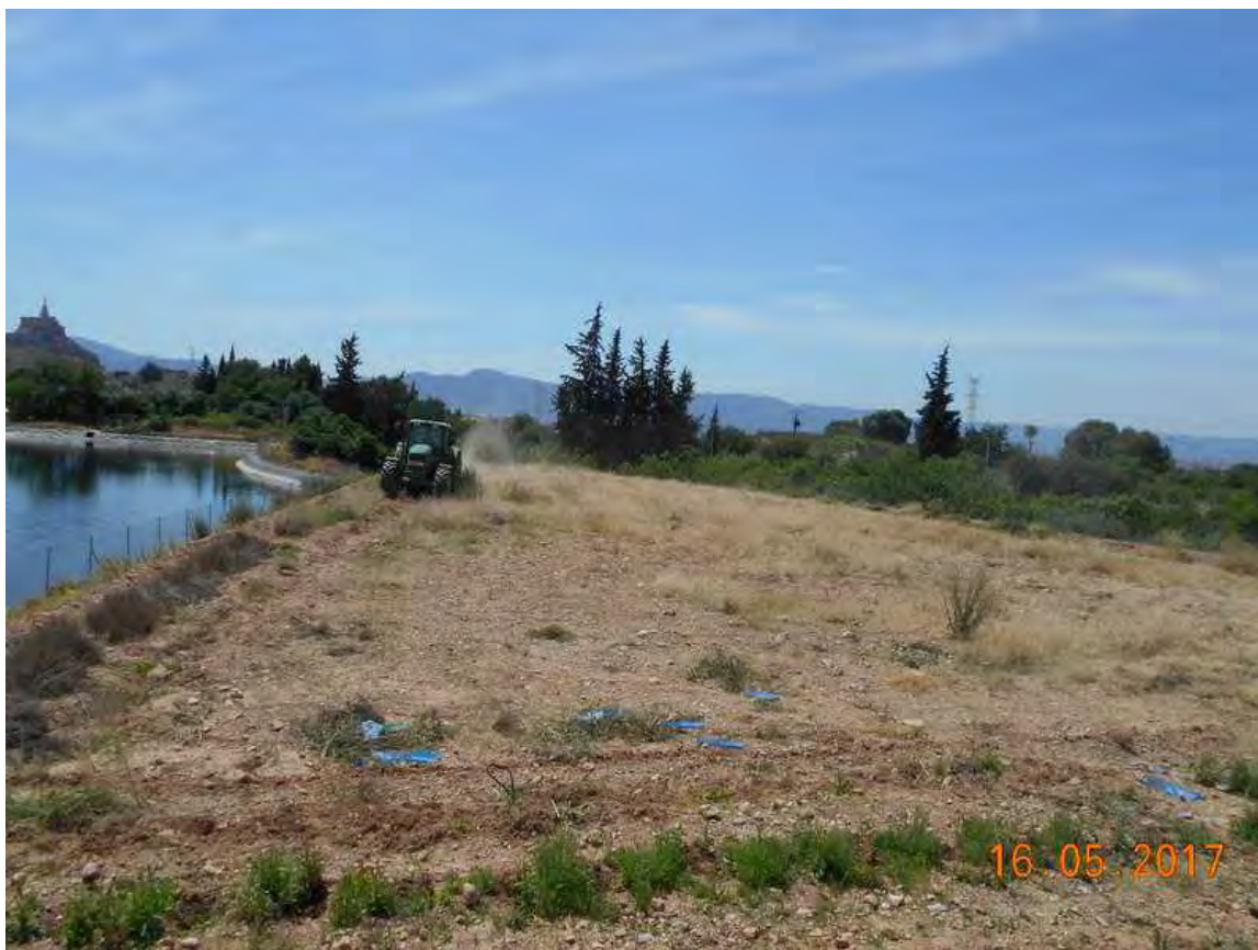
Fotografía 1. Preparación del terreno
