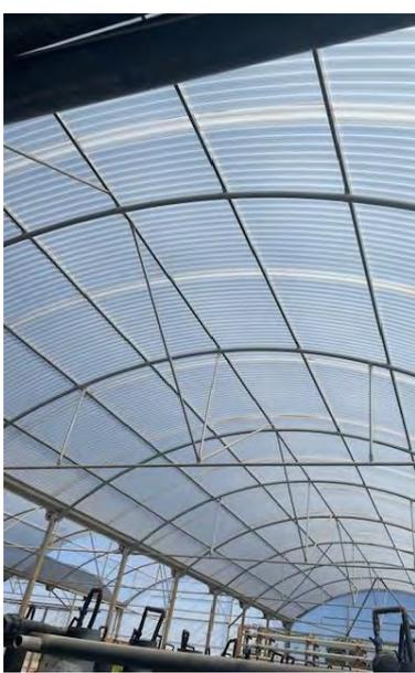
Foto 1: Detalle instalación policarbonato.
