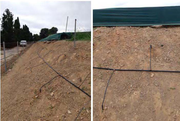
**Foto 28. Instalación de los microtubos para riego y detalle de los mismos (14/11/2019).**
