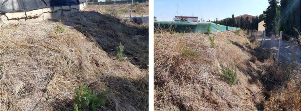
**Foto 86. Incorporación a los taludes de balsa y embalse de restos de podas y desbroce.**
