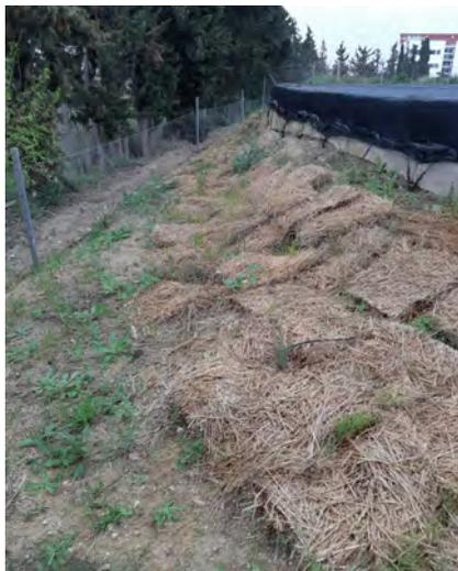
**Foto 85. Prevención de erosión con mulching de paja en talud de embalse (18/02/2020).**
