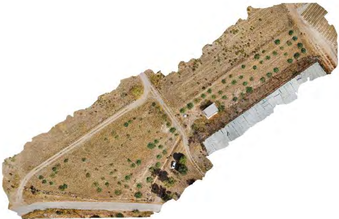
Figura 9. Vista aérea de las parcelas 1 y 2 (septiembre de 2022).
