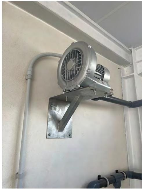
Imagen nº 6: Bomba aire para removedor de tanques de abono
