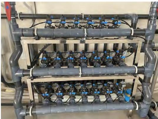
Imagen nº 3: Electroválvulas y manómetros
