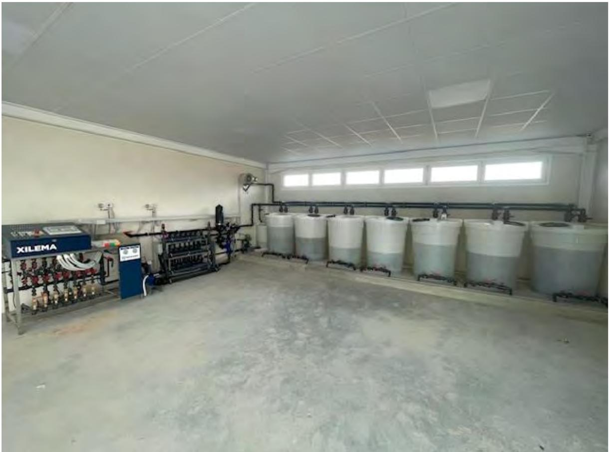
Imagen nº 9. Vista general de la instalación del cabezal de riego de última tecnología.
