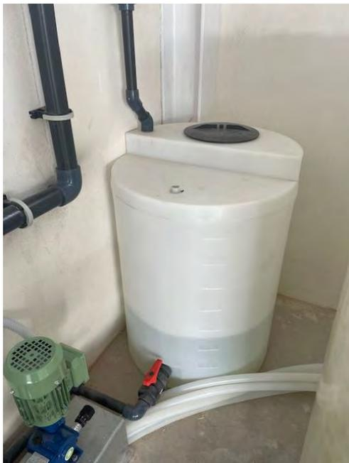
Imagen nº 5: Inyector y tanque de nutrientes especiales
