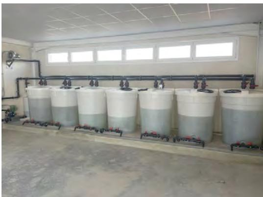
Imagen nº 7: Detalle línea depósitos abono
