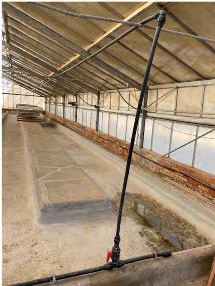
Foto nº 2: Vista de la derivación del nuevo sector de riego.
