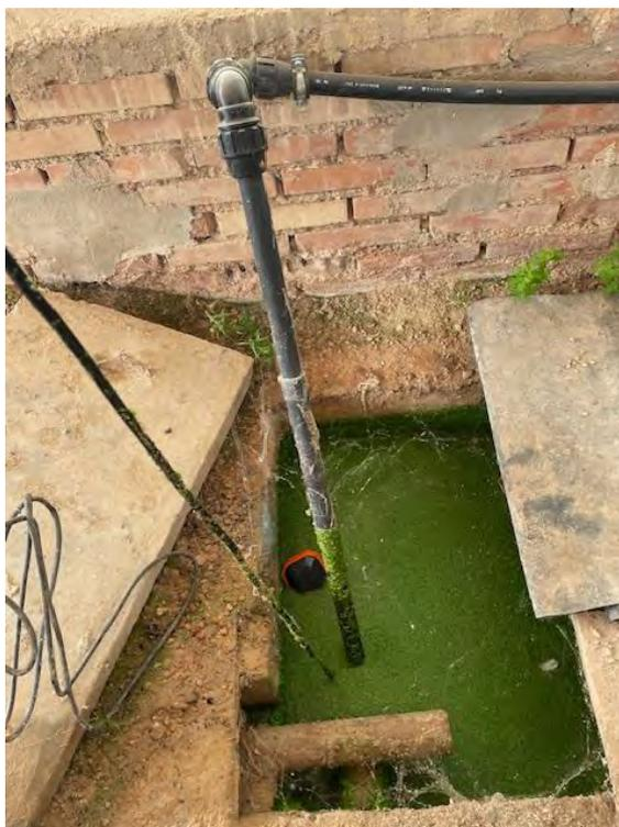
Foto nº 4: Detalle de la instalación de la electrobomba en la arqueta recogida lixiviados del cultivo de higueras.
