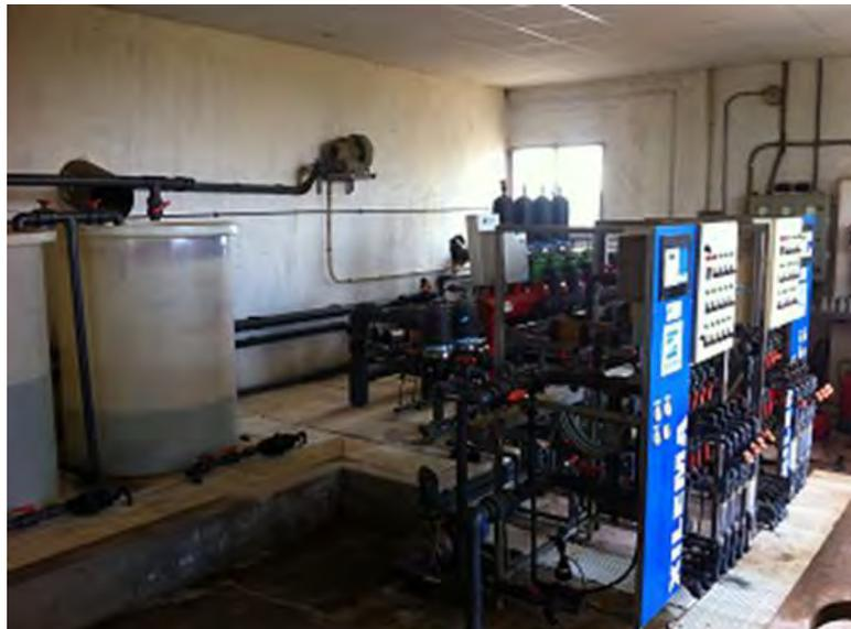
Fig.4. Equipo de fertirrigación
