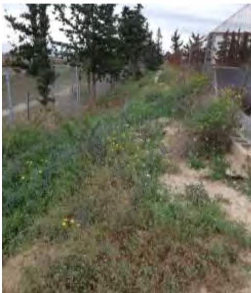
Foto nº 10. Situación inicial de los taludes a revegetar (10/11/2019).
