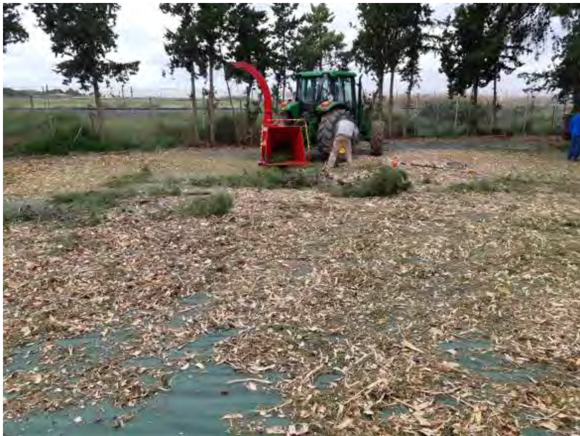
Foto nº 13. Colocación de malla antihierba de polifibril y mulching de corteza de pino (20/12/2019).
