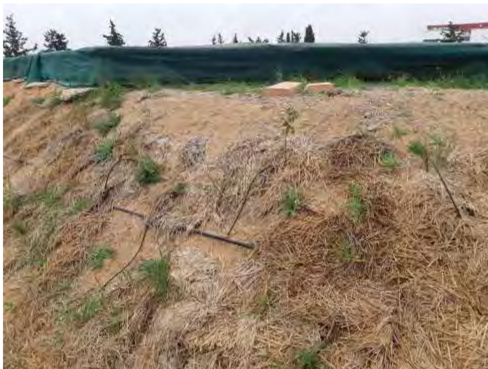
Foto nº 20. Estado vegetativo del talud del embalse (18/02/2020).
