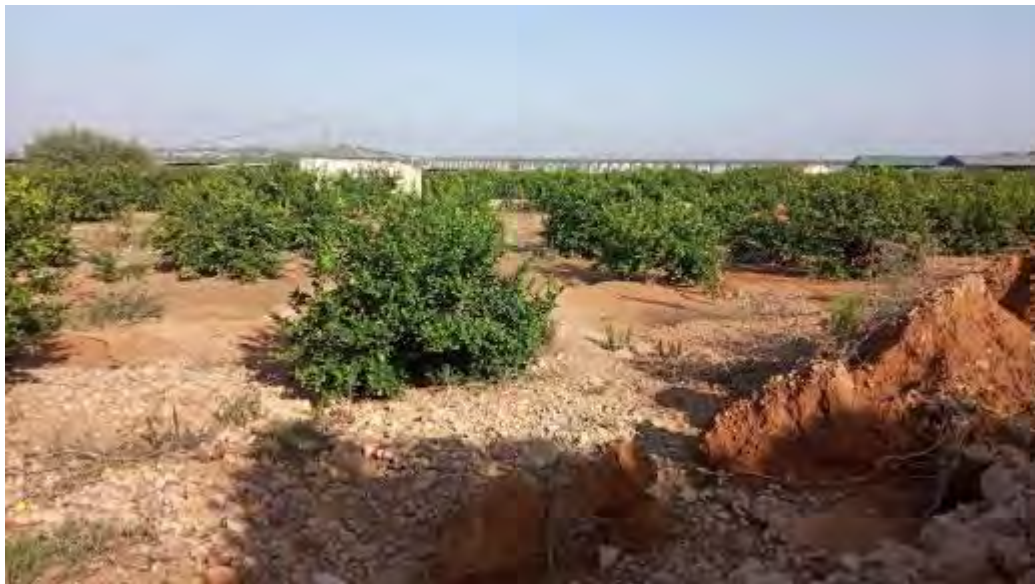
Daños producidos por arrastres y acumulación de tierras.
