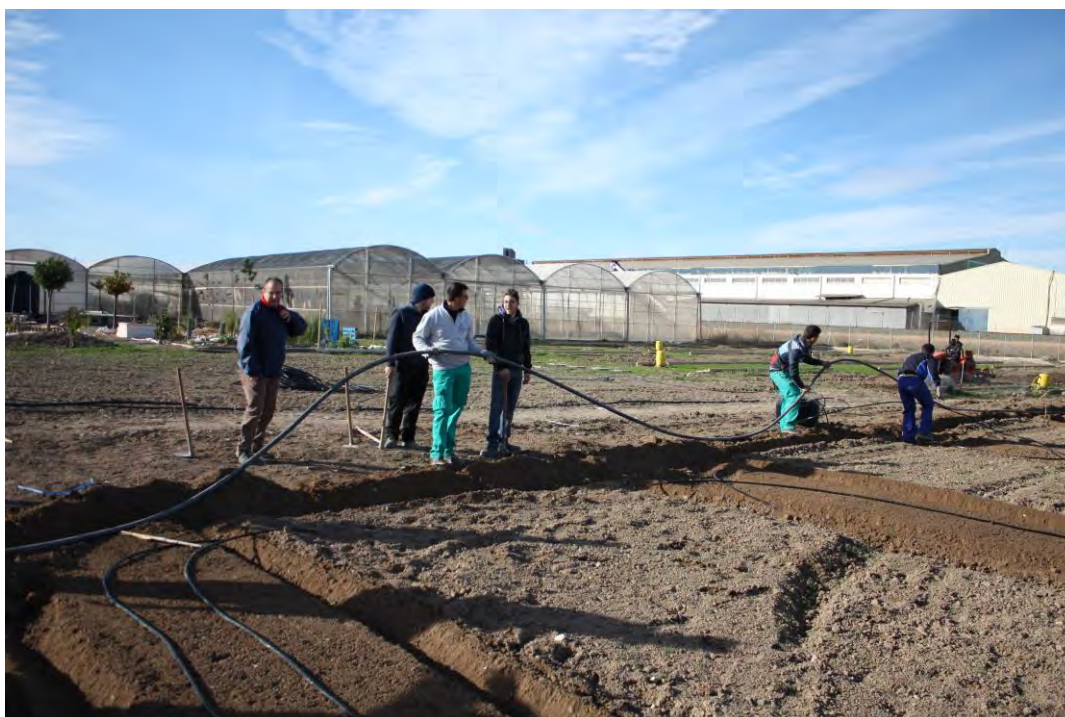
Foto nº 1. Aspecto de la instalación de riego para la plantación de almendros en enero de 2010.
