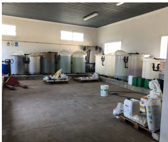
Cabezal de riego
