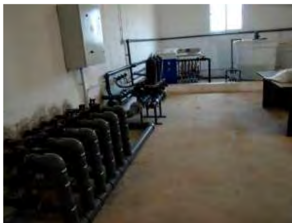
Cabezal de riego de Las Nogueras de Arriba.
