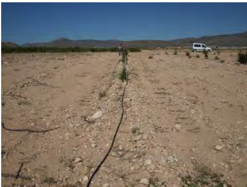
Instalación de aspersores
