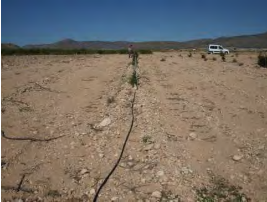
Instalación de aspersores
