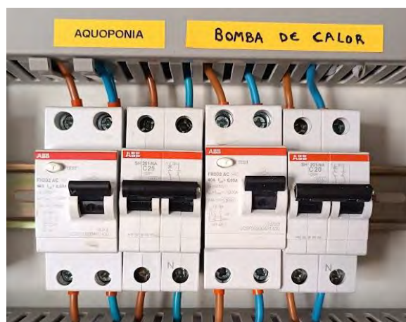
Diferenciales instalados
