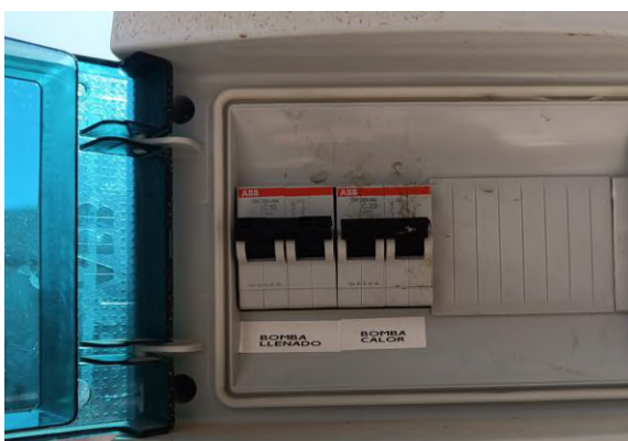
Magnetotérmicos instalados
