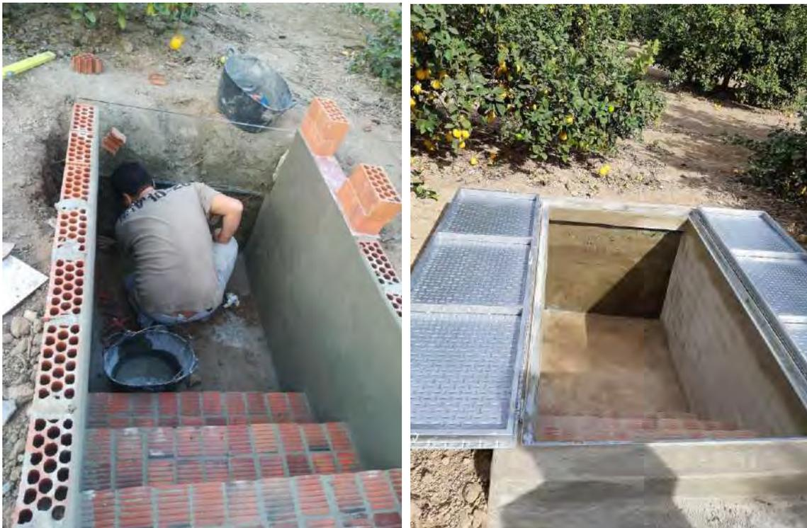
La siguiente fotografía muestra el aspecto actual de la arqueta, dónde se observa la tubería portagoteros y el bulbo húmedo:
