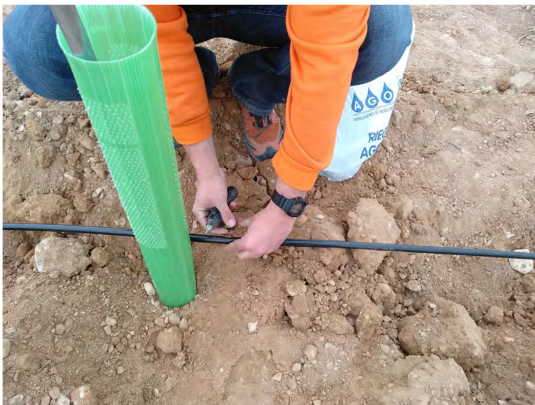
Foto 4: Extendido y pinchado de tuberías.
