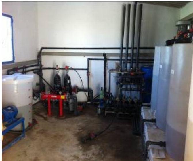
Fig. 2. Detalle del cabezal de riego
