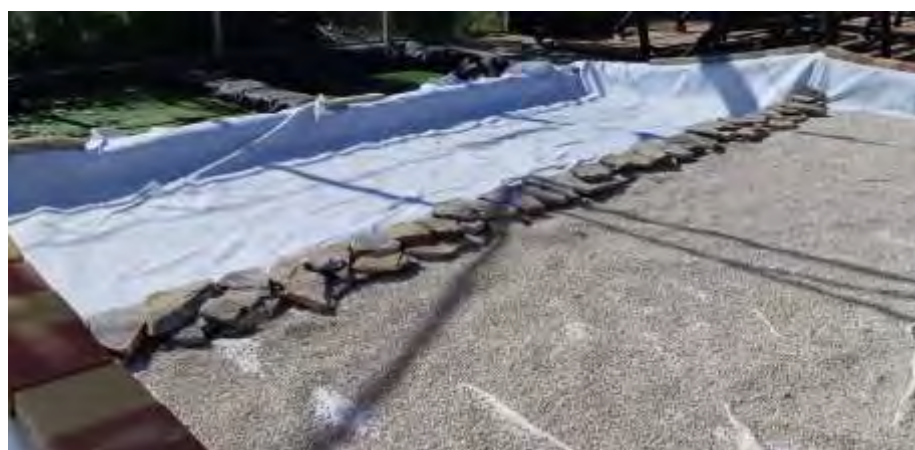
Foto 10. Nuevo sistema de tres balsas filtrantes (21/06/2021).
