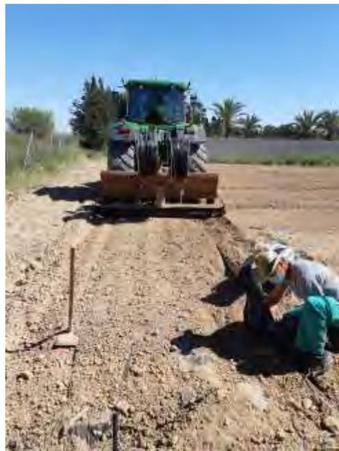
Foto nº 13. Colocación de plástico y tuberías portagoteros debajo para riego subterráneo (14 de mayo de 2021).
