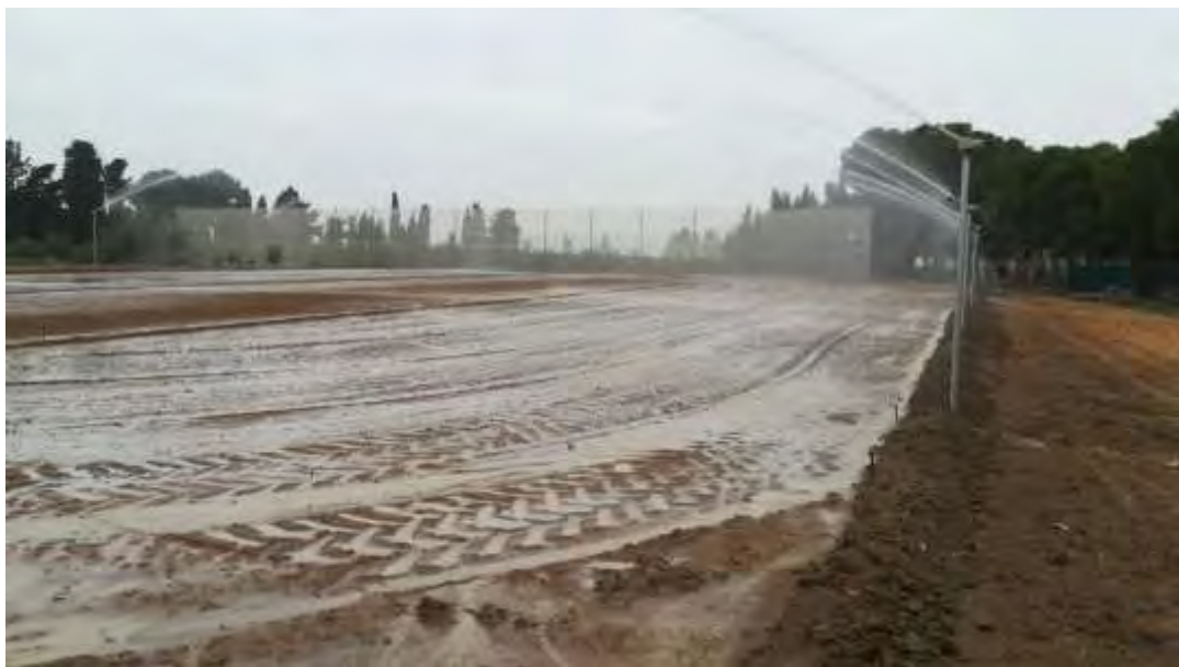
Foto nº 11. Prueba de aspersores (22/11/2021).
