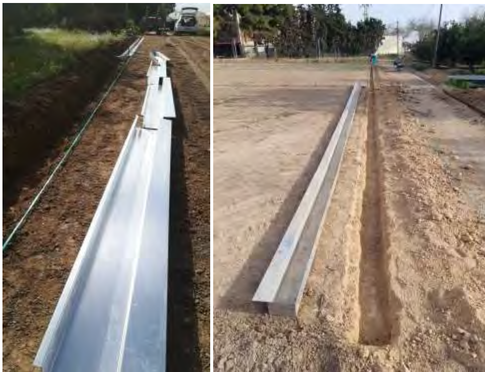
Foto nº 12. Acequia de recogida de drenajes (17/11/2021).
