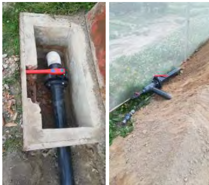
Foto nº 9. Arquetas y válvulas de riego (17/11/2021).
