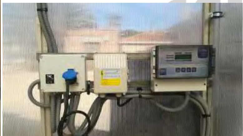
Foto nº 10. Caudalímetro para el control de volumen drenado y programador del riego.
