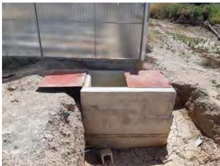
Foto nº 7. Construcción arqueta recogida drenajes hidropónicos.
