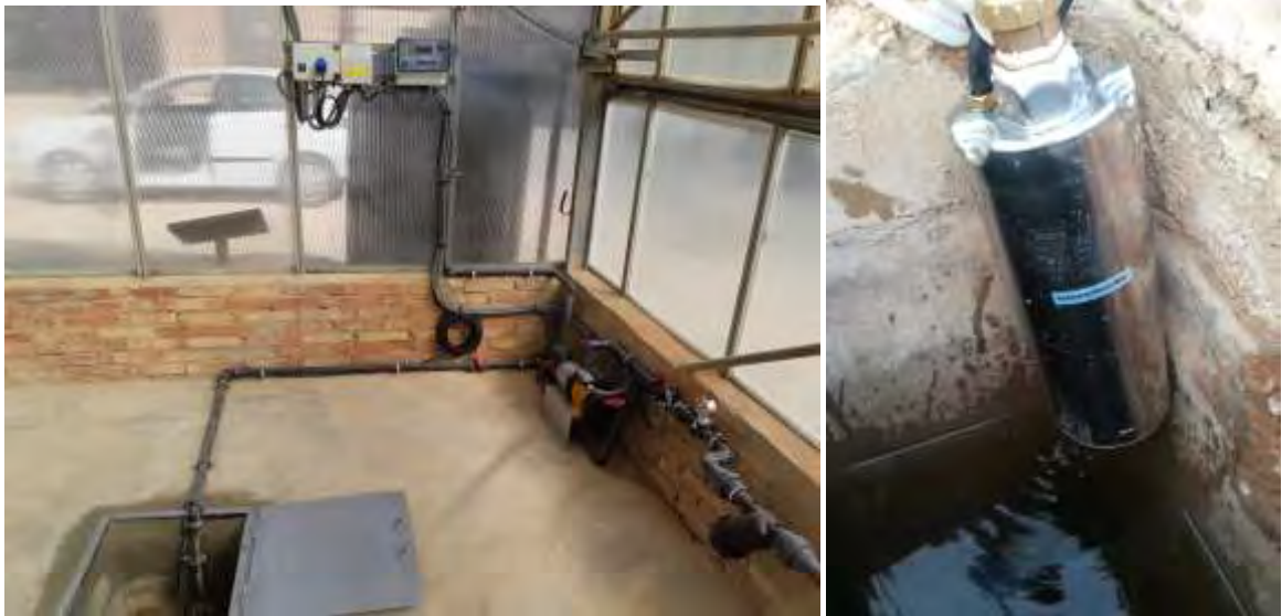
Foto nº 9. Programador de riego, bombas y dispositivos de riego en invernadero de recirculación.
