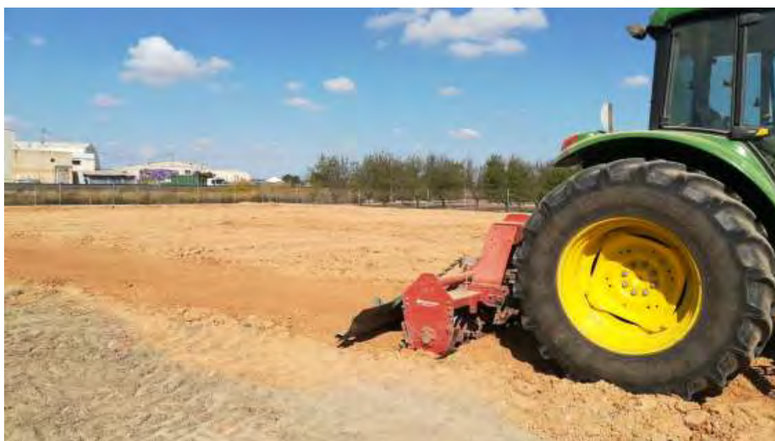
Pase de rotovator tras la terminación de las obras (14/10/2021).
