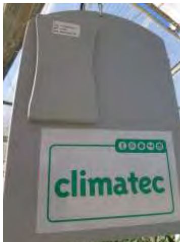
Foto 5. Psicrómetro para el control de la humedad en el invernadero (15/02/2022).
