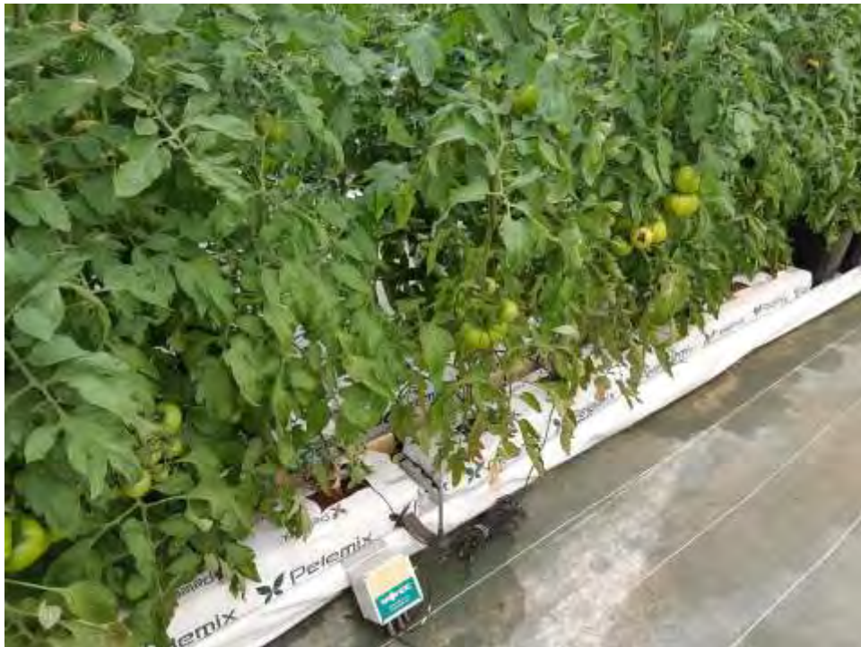
Foto 4. Dispositivo de control del riego (22/04/2021)
