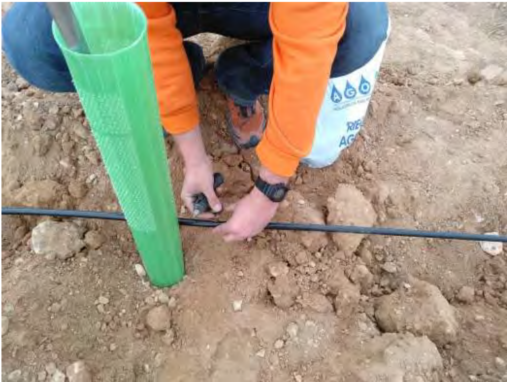
Foto 3: Extendido y pinchado de tuberías
