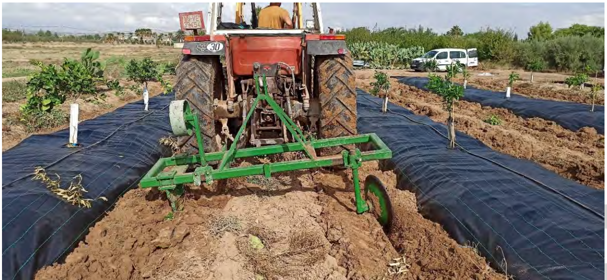
Instalación malla antihierba.
