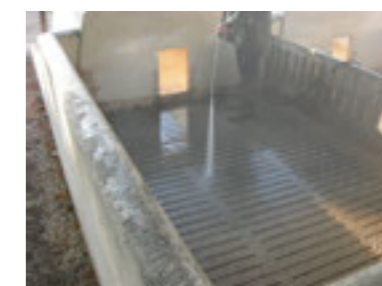
Limpieza con agua a presión
