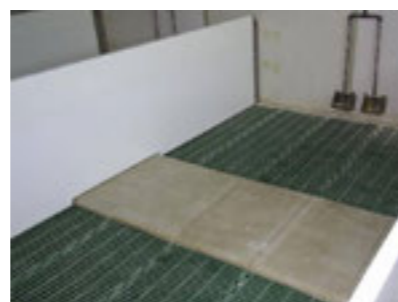
Suelo de rejilla desmontable
