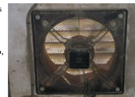
Sistema de ventilación
