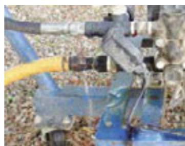
pérdida por una fuga
