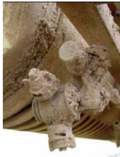
Boquillas obstruidas por suciedad
