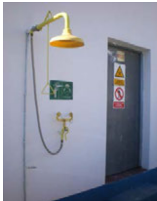
Ducha lavajos en el acceso al almacén de fitosanitarios
