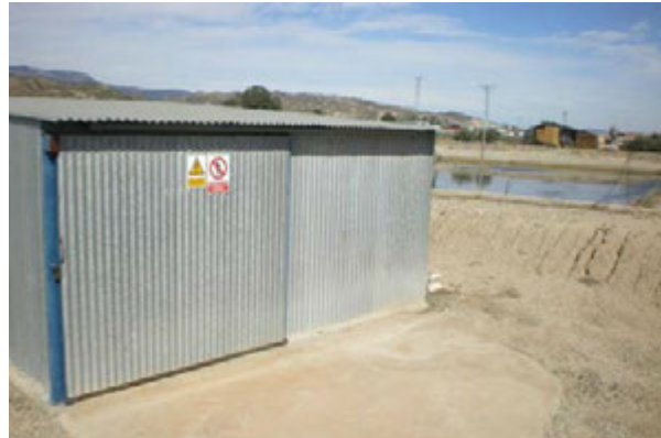
Caseta para cabezal de riego y almacenamiento de fitosanitarios y fertilizantes, separada de viviendas y granjas
