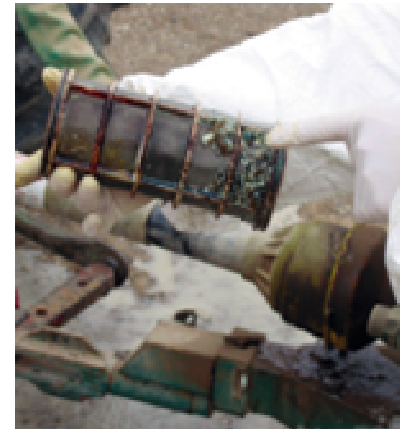
Filtro obstruido por suciedad
