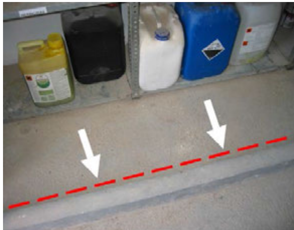
Reborde a modo de cubeto en estanterías para fitosanitarios
