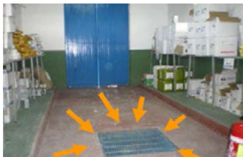
Almacén con colector de desagüe conectado a una fosa impermeable exterior
