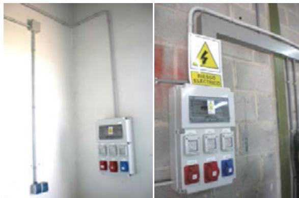
Instalaciones eléctricas en casetas agrícolas conforme al reglamento REBT
