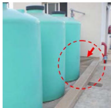
Lámina plástica de polietileno recubriendo el cubeto para protegerlo de la posible corrosión provocada por derrames o fugas de fertilizantes de reacción ácida
