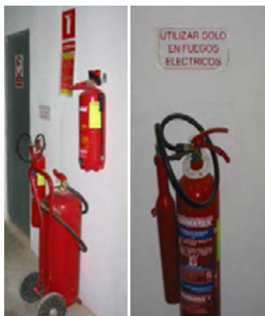
Equipo de extinción de incendios, extintor de CO 2 para fuegos eléctricos
