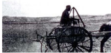
pulverizador de carro con bomba accionada por los ejes
