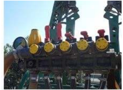
Regulador distribuidor de caudal
