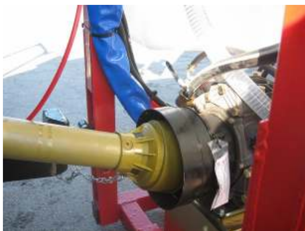
Comprobación de la protección de la transmisión cardánica del eje y la campana de la bomba.
