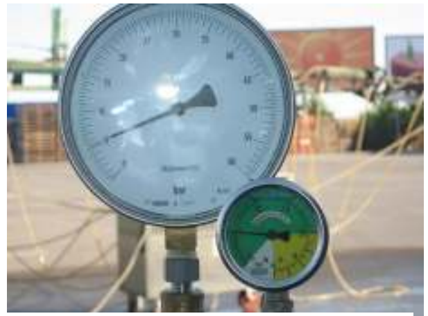
Comprobación del manómetro, subiendo la presión y después bajando.
