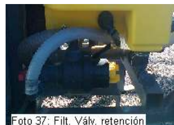
Foto 37: Filt. Válv. retención
