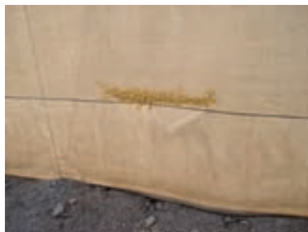
Fotos 54, 55 y 56 (abajo). Reparación de mallas rotas en los cerramientos.
