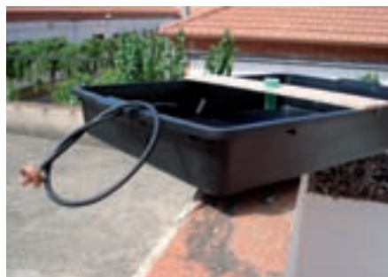
Foto 66. Sistema de abastecimiento de agua.
