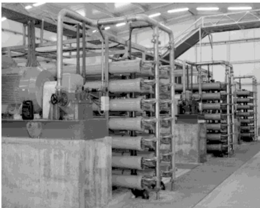
Foto 8.2. Nuevos recursos de agua. Planta desaladora de la C. R. de Águilas.
