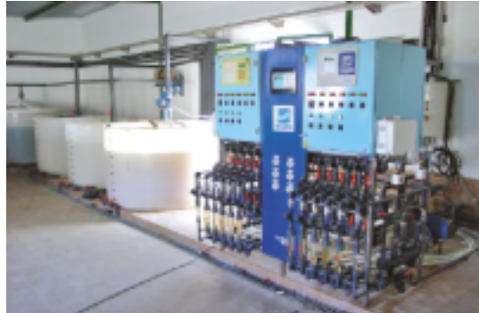
Fig. 2.1. Detalle del cabezal de riego.
