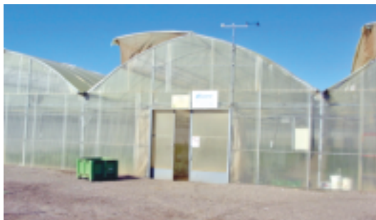
Fig. 2.3. Vista exterior del Invernadero experimental nº 2.
