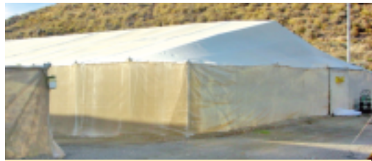
Fig. 2.8. Vista exterior de la Malla experimental nº 2.
