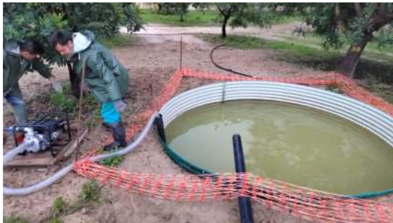
Foto 25. Extracción del agua de los depósitos (04/04/2022).
