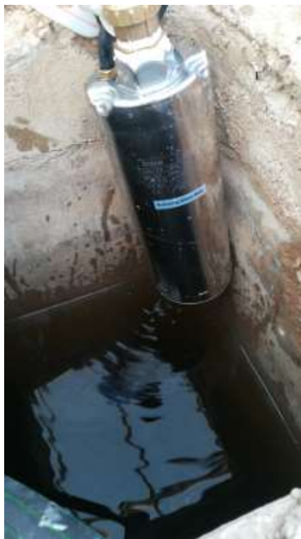
Foto nº 5. Foso de recogida de drenajes del invernadero hidropónico y depósito de mezclas para riego de higueras (04/02/2022).
