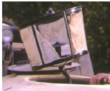
Filtro de llenado en condiciones claramente no aceptables.
