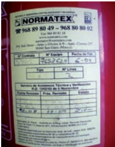
Etiqueta mantenimiento extintor.
