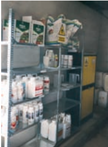
Estantería de productos fitosanitarios con cubeto de seguridad.
