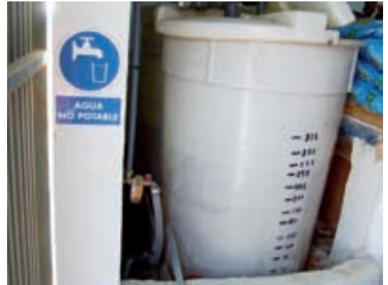
Señal de advertencia de agua no potable destinada únicamente a riego o limpieza.
