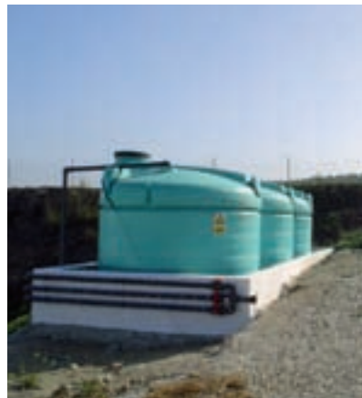
Depósitos de abono concentrado con cubeto de seguridad.
