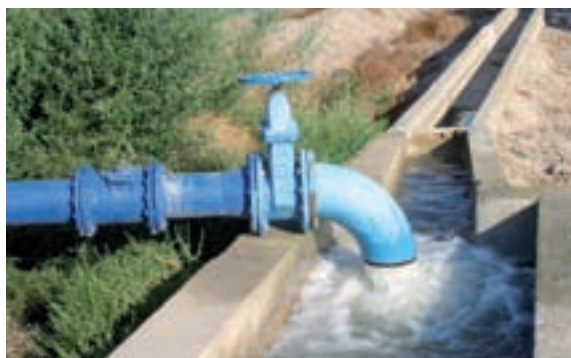
Detalle de un canal de riego.
