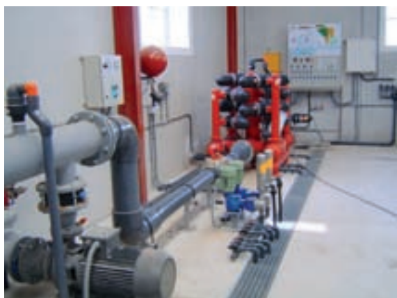
Interior de un cabezal de riego correctamente diseñado.
