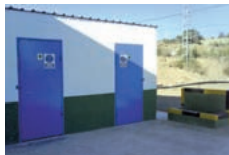
Aseos y punto de agua potable en explotación de tomate en invernadero.
