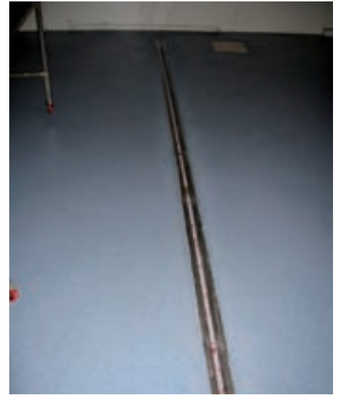
Canalización en suelo.
