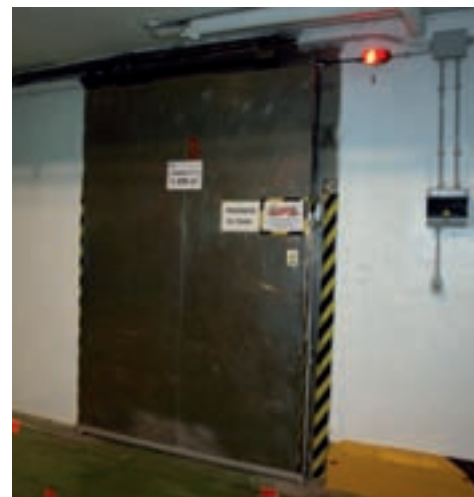
Puerta de acceso a cámara frigorífica.
