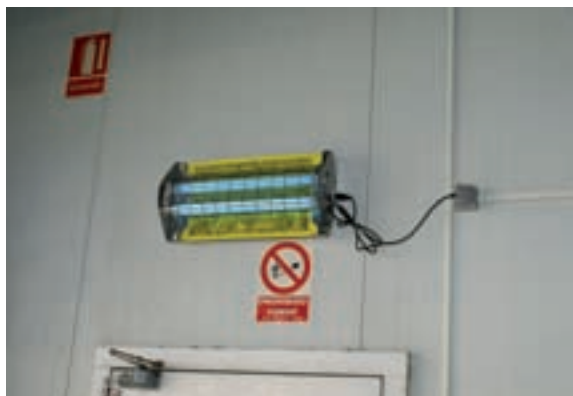
Desinsectación activa con mosquitera.
