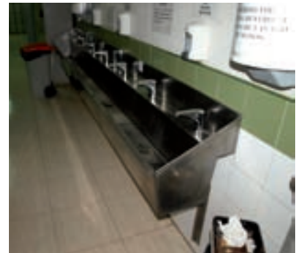
Sistema de lavado de manos no manual.
