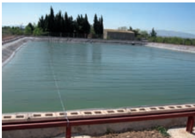
Fotografía 2.1: Embalse cubierto para disminuir la evaporación y el crecimiento de materia orgánica en el agua.
