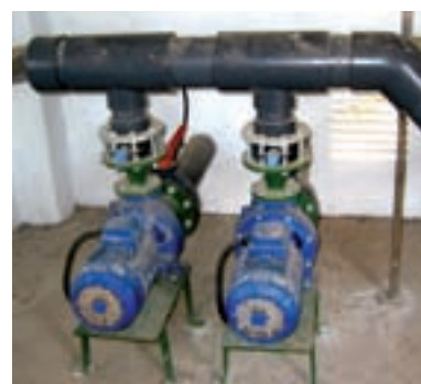
Fotografía 3.2: Equipo de bombeo.
