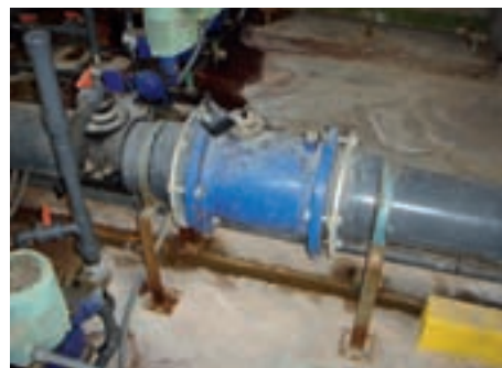
Fotografía 1.14: Foto contador Waltman.
