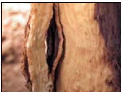
Madera rizada. Daños en corteza y madera.
