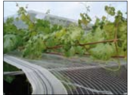
Daños en parral.
