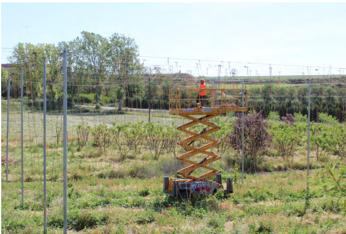
Inicio de atado de los tutores en la línea horizontal que sustenta las lianas de producción de lúpulo en el CDA Las Nogueras de Arriba, Caravaca (24/05/2022).
